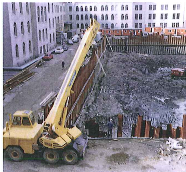
Rivningen har börjat 1969
