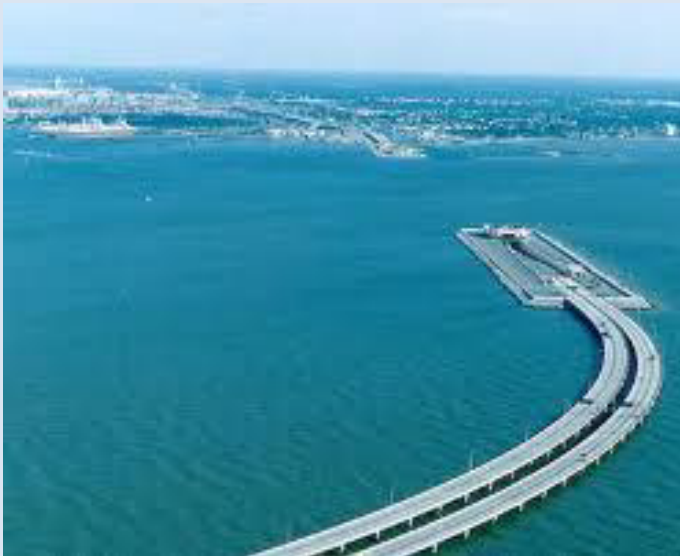
Öresundsbrons övergång till tunnel
